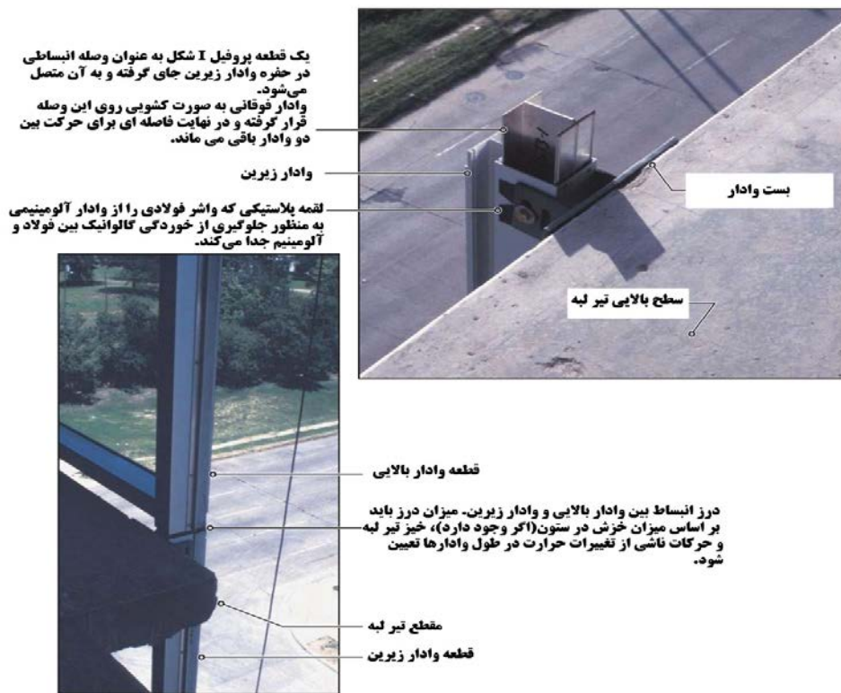
شکل ۹-۷- نمونه اتصال انبساطی بین دو قطعه وادار
