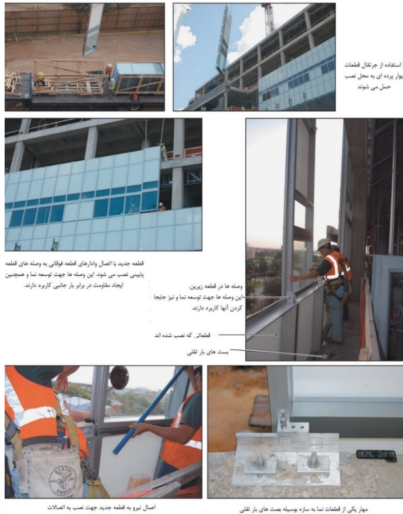
شکل ۹-۱۲- مراحل نصب نمای پرده‌ای یکپارچه
