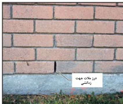
شکل ۵-۱۳- خالی گذاشتن درز ملات جهت زه‌کشی
