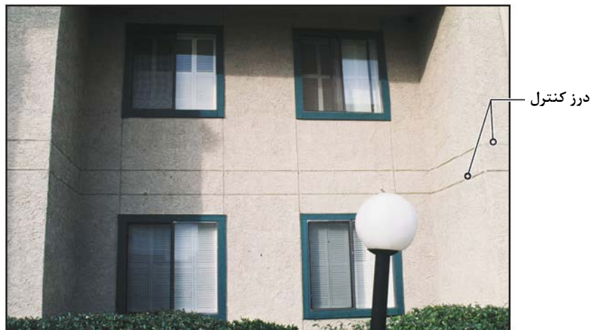
شکل ۶-۲- نمونه درزهای کنترل بر روی نمای سیمانی
